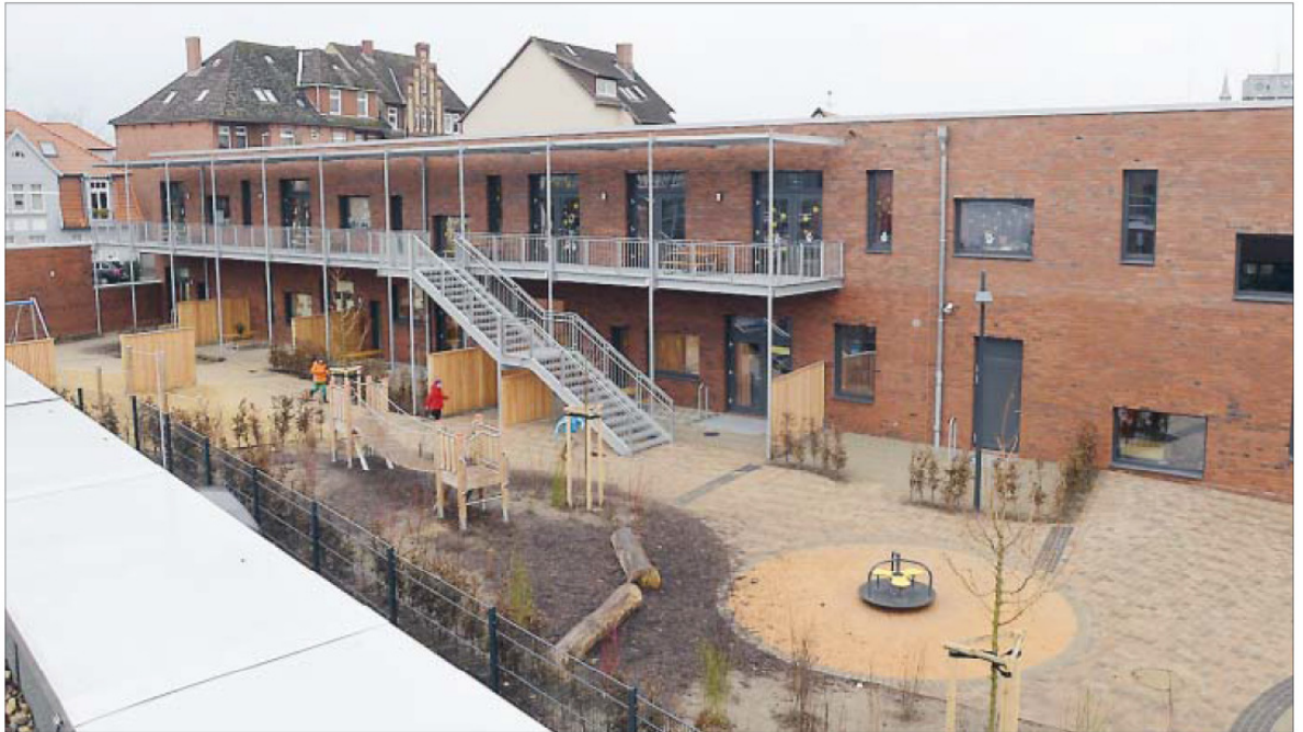
Rund 100 000 Euro würde die Photovoltaikanlage kosten, die die Zukunftsgenossen auf dem Dach der St.-Ursula-Schule installieren möchten. Dazu brauchen sie allerdings noch weitere Genossen, die Geldeinlagen einbringen.
